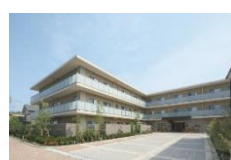
井の頭シルバーマンション (グランタ井の頭公園) 東京都三鷹市
